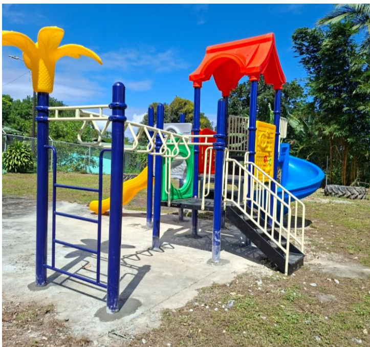
Ilustración 72. Entrega de módulos infantiles Entrega e instalación de Parque Infantil Concepción de la Palmera
